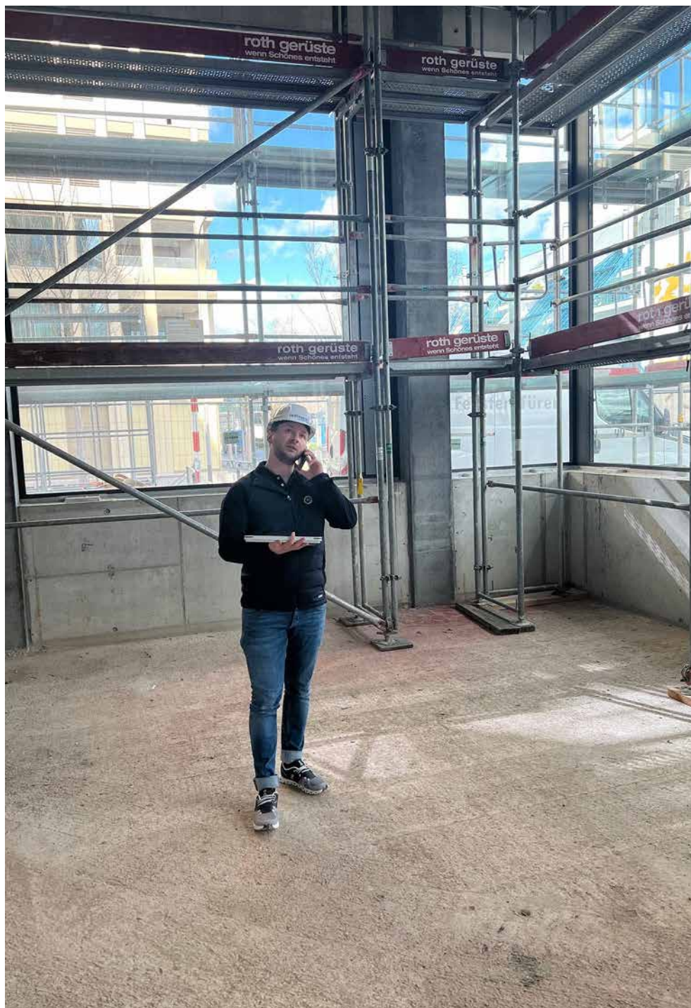
Patrick Stalder unterstützt vor Ort auf der Baustelle sowohl mit Planungsaufgaben, als auch mit dem Verbauen der Hardware.
